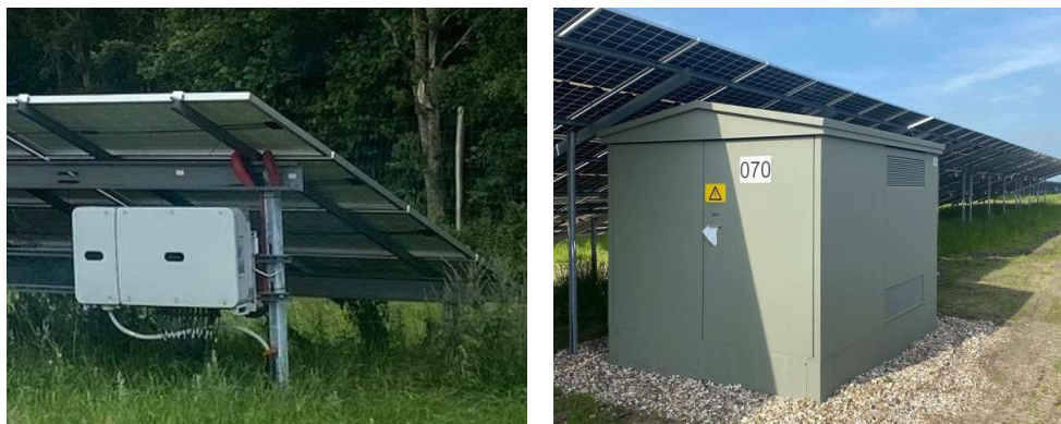
Figur 1-5 Eksempel på inverter (t.v.) og transformer (t.h.).
