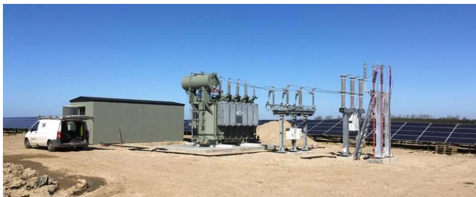
Figur 1-6 Eksempel på stepup-transformer og teknikbygning.
