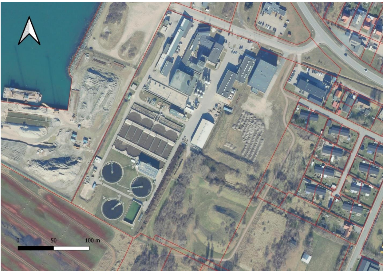
1: I forbindelse med kapacitetsforøgelsen af renseanlægget skal den sydlige del af renseanlæggets matrikel, hvor der i dag er shelterplads, inddrages til anlæg der kan forbedre renseprocessen.
