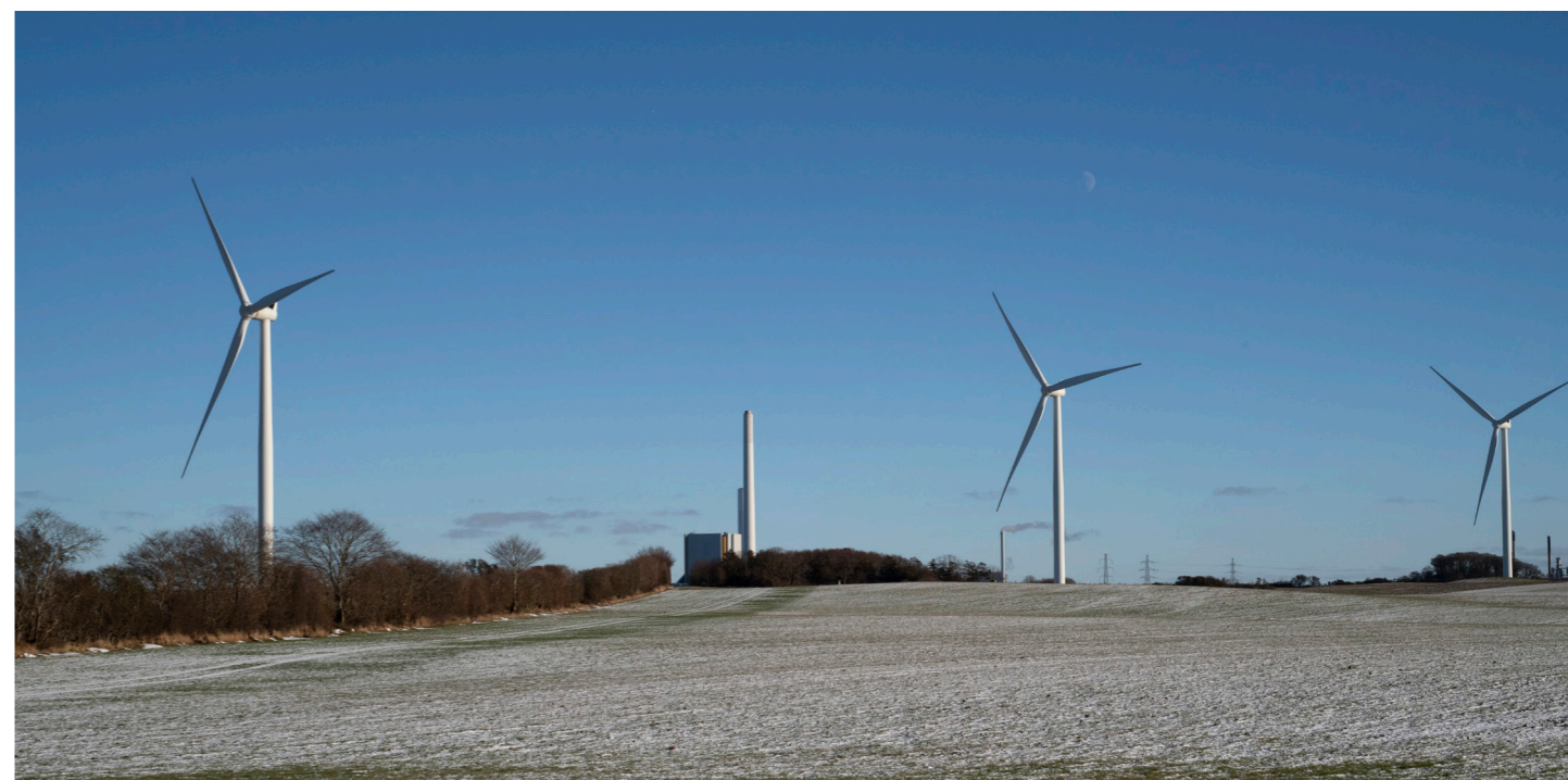
Kig henover projektområdet fra Østrupvej mod nordøst. Levende hegn langs Asnæs Skovvej, vindmøller, kraftværk, højspændingsmaster og skorstone fra raffinaderi.
