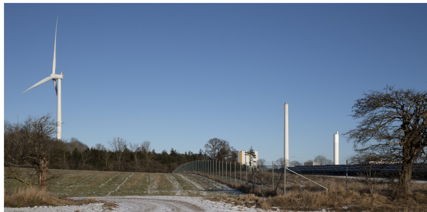
Kig til eksisterende solcelleanlæg fra den rekreative sti mellem de to skovpartier. Desuden vindmølle og Asnæsværket.
