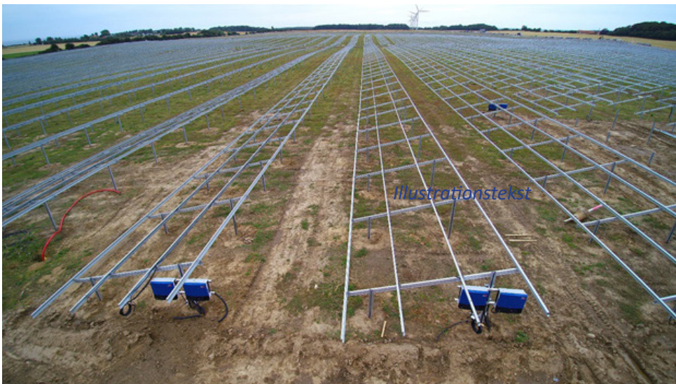
Foto 3. Aluminiumsstativer påsat invertere (blå)
