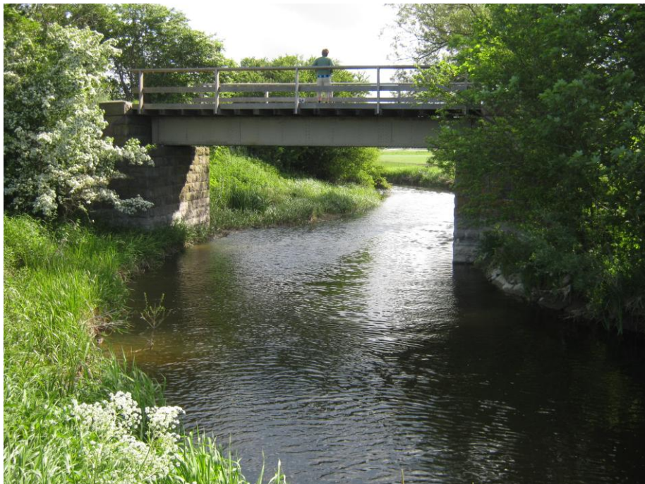
Figur 12. Nedre Halleby Å og den kraftige bro over åen. Foto CC.
