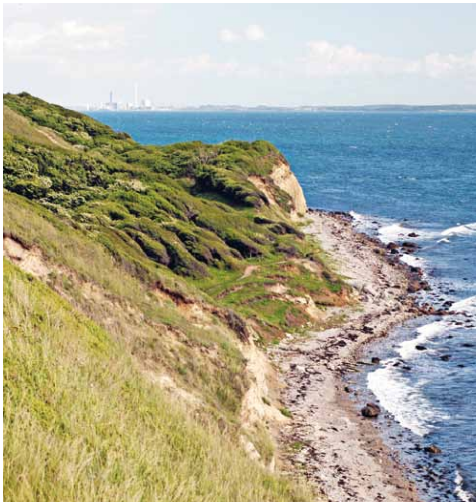
Figur 131. Vindekilde. Skræntmateriale med plastisk ler er gledet helt ned på stranden. OA 29-5-06.
