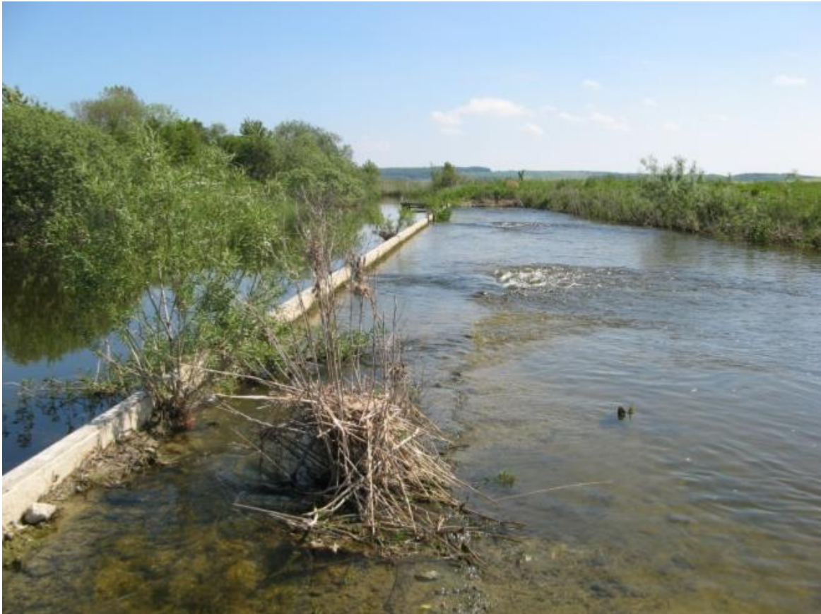
Figur 1-3 Overløbskant ved omløbsstryget. Der ses flow ved to udskæringer i spunsvæggen.
