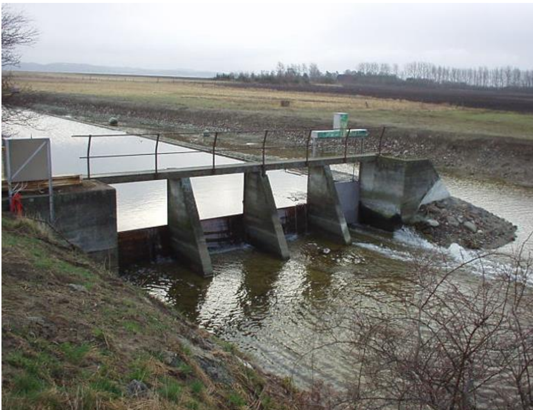
Figur 1-1 Stemmeværket med tre manuelle slug samt en automatisk port. Omløbsstryget ses i baggrunden.
