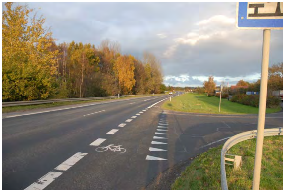
Foto 13. Udkørsel til Kalundborg vej i fremlagt forslag ligger placeret umiddelbart op af Bregninge Å's krydsning af Kalundborgvej.
