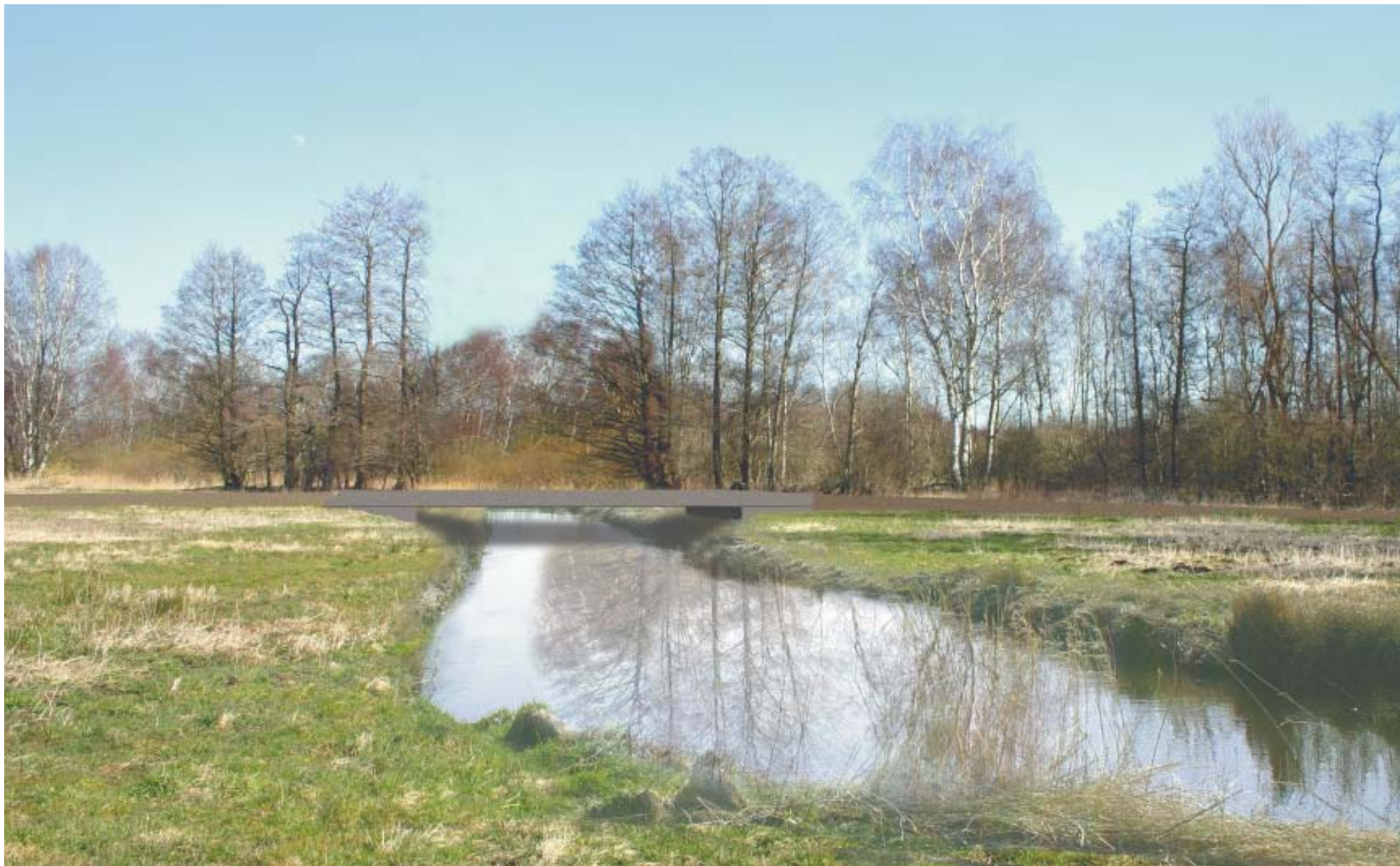
Visualisering af genslyngning af å med ny bro til transport af råstoffer. Broen gøres så bred, at banketterne langs åen kan føres under
