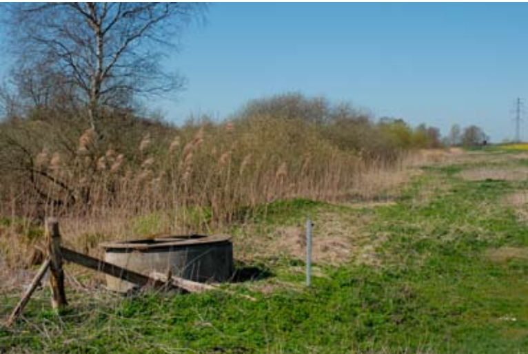
Foto 3. Eksisterende markvandingsboring syd for Bregningegårdens arealer. Boringen vurderes at kunne benyttes som pejleboring ifm. monitoring af gravearbejdernes monitoring af grundvandsstand.
